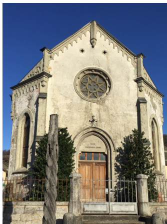
Chapelle de Nagelin, à g. remplage
